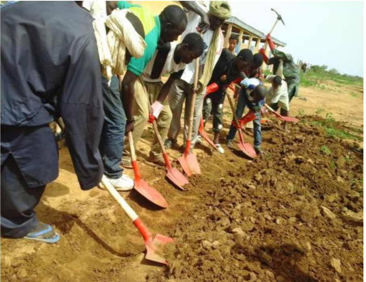
L'équipe des pelleurs creuse les nouveaux caniveaux.
