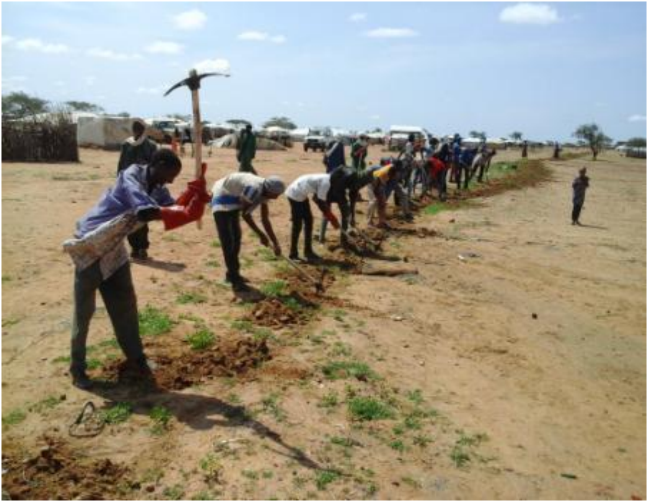
L'équipe des piocheurs creuse les nouveaux caniveaux.
