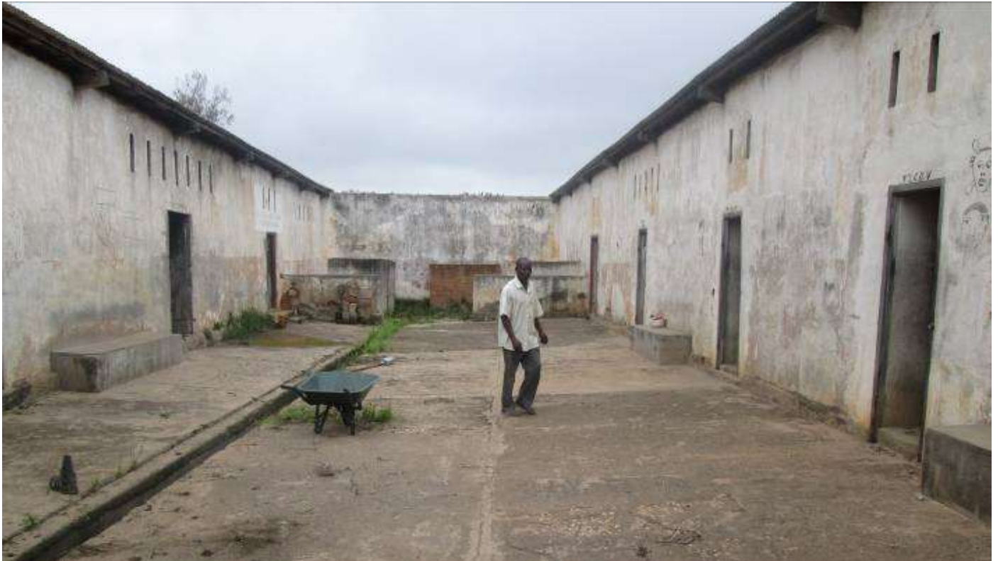
Intérieur de l'ancien bâtiment de la Maison d'arrêt de Bouar.
