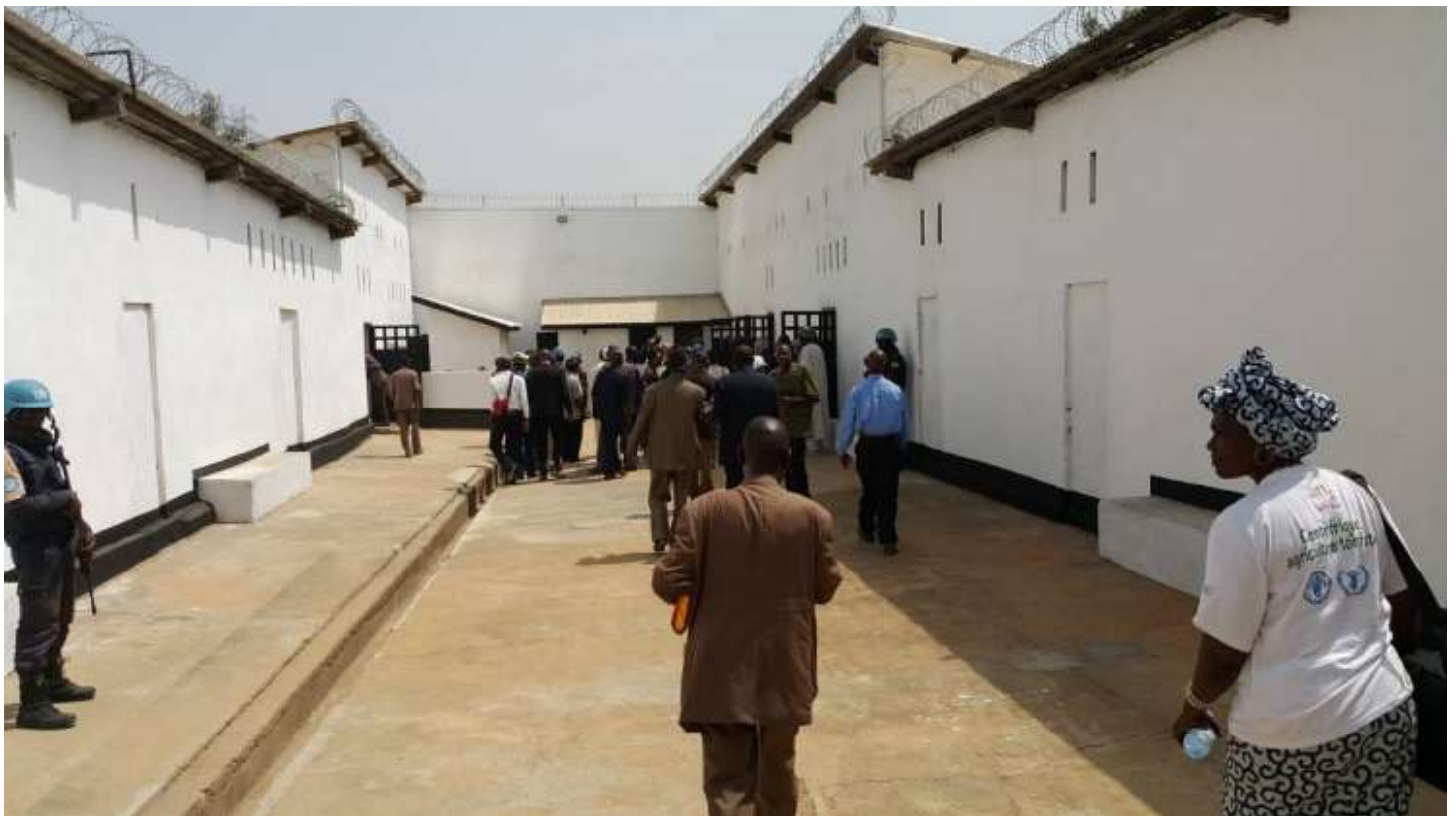
Intérieur de la Maison d'arrêt de Bouar après sa restauration.
